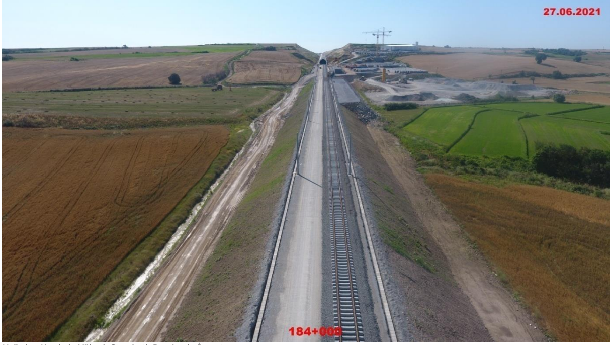
Halkalı – Kapıkule Yüksek Standartlı Demiryolu İnşaatı
