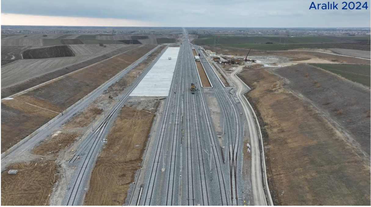
Halkalı – Kapıkule Yüksek Standartlı Demiryolu İnşaatı
