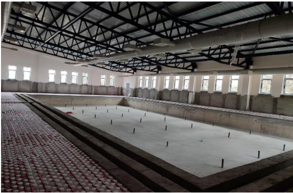
Lüleburgaz Yüzme Havuzu
