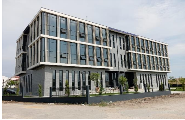
Tapu ve Kadastro Hizmet Binası
