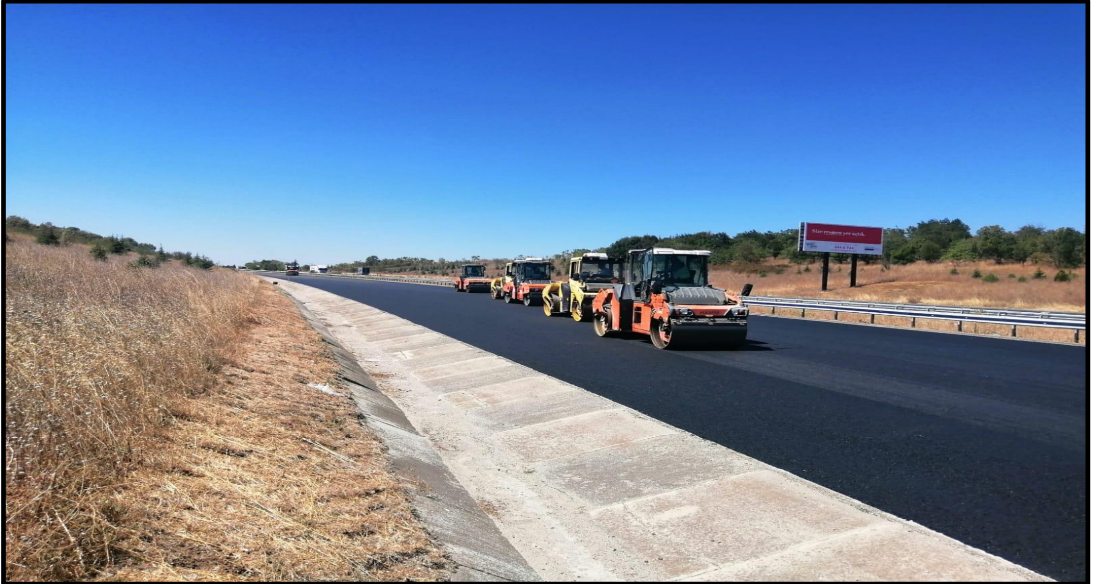
Lüleburgaz-Saray Kavşağı Arası O3/07 Km:13+000 (İstanbul Yönü)
