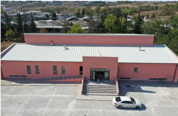
Lüleburgaz Yüzme Havuzu
