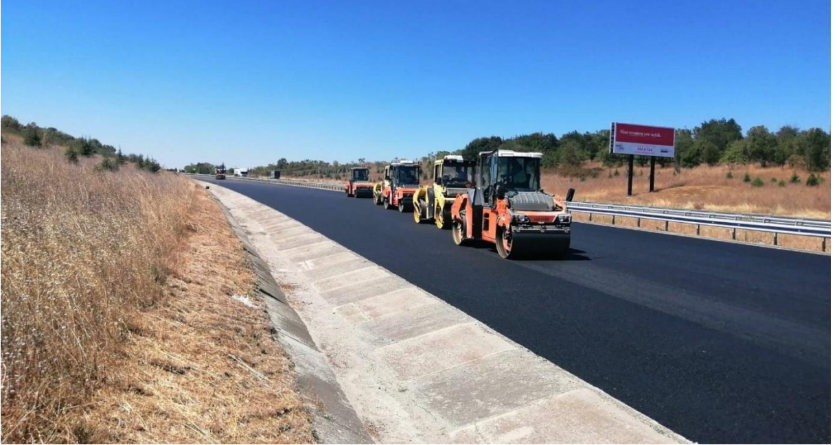
TEM Otoyolu Üstyapı İyileştirilmesi ve Büyük Onarımı
