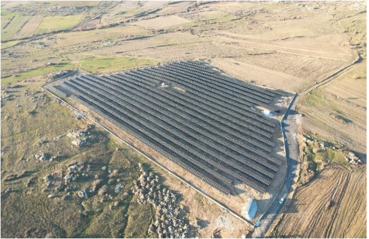
Karakoç Güneş Enerji Santrali
