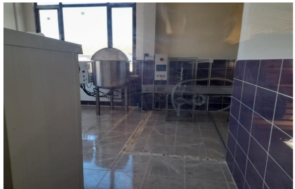
Demirköy Bal Dolum Tesisi
