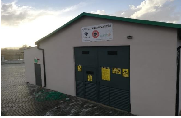
Çakıllı paket atıksu arıtma tesisi
