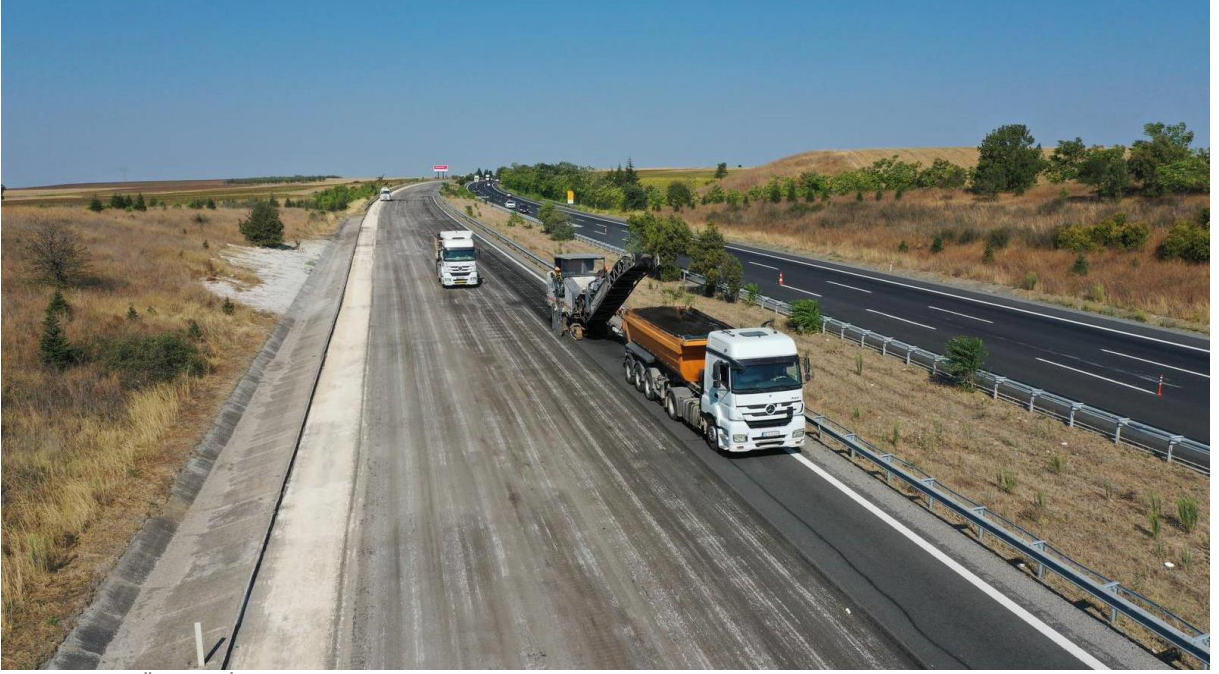
TEM Otoyolu Üstyapı İyileştirilmesi ve Büyük Onarımı
