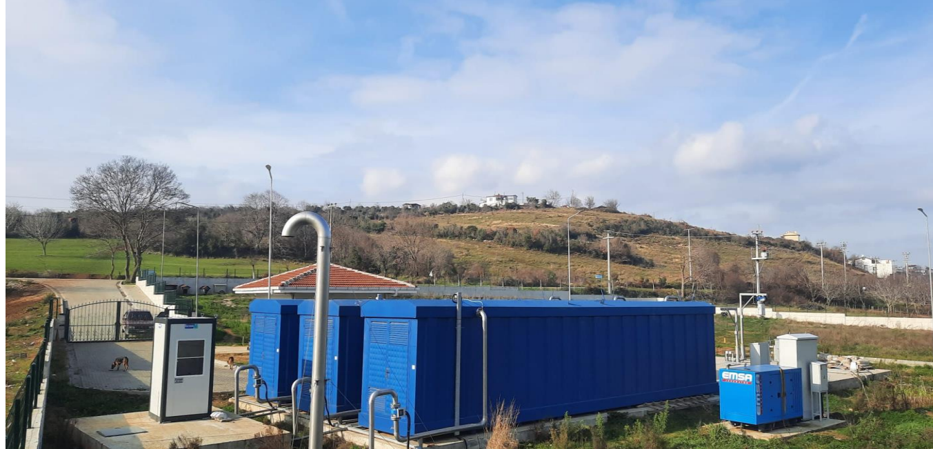
Kırıkköy Paket Atıksu Arıtma Tesisi İkmal İnşaatı
