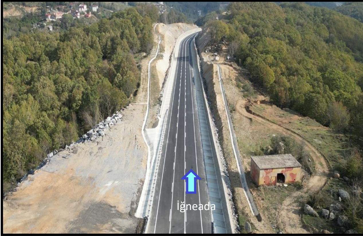
Demirköy Çevre Yolu
