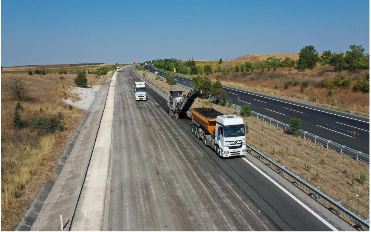
TEM Otoyolu Üstyapı İyileştirmesi ve Büyük Onarımı
