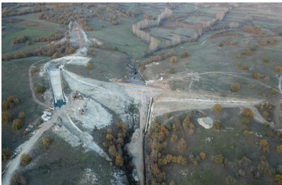
Pınarhisar Yenice Barajı
