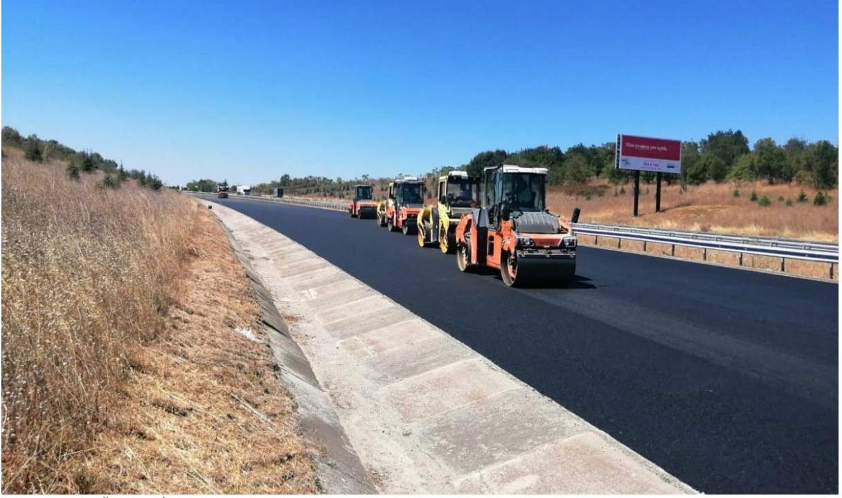
TEM Otoyolu Üstyapı İyileştirmesi ve Büyük Onarımı
