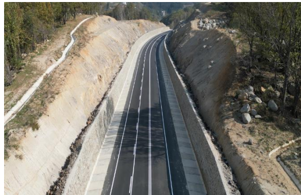
Demirköy çevre yolu
