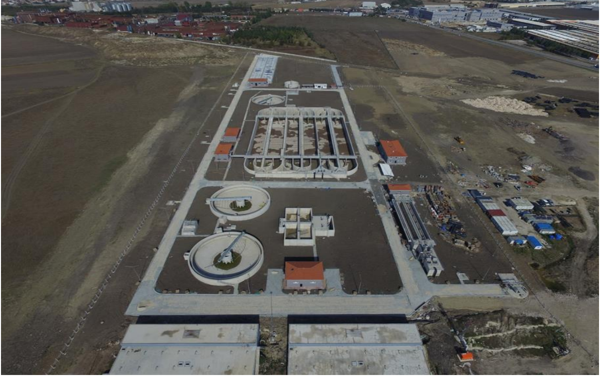
Büyükkarıştıran OSB Atıksu Arıtma Tesisi
